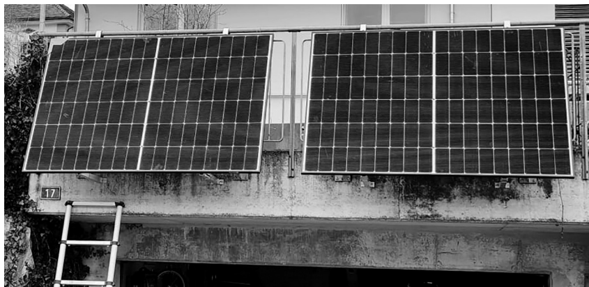
Beispiel der Installation einer Plug-and-Play Solaranlage an einem Terrassengeländer.
