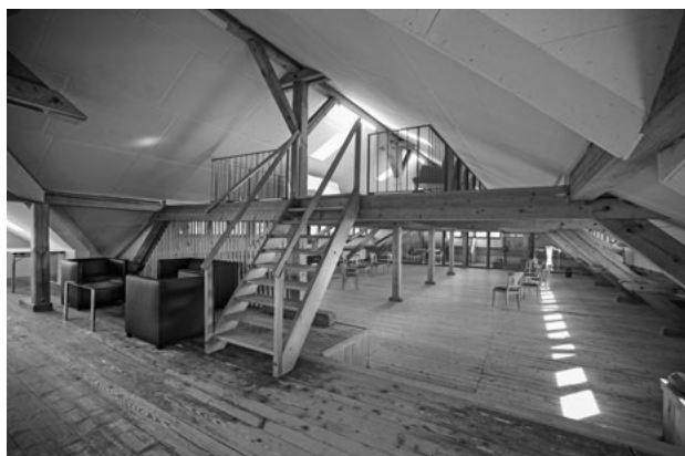
Der grosse Hauptraum im Dachstock bietet viel Platz.
